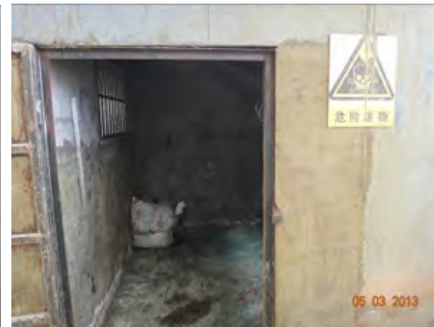
危险废物贮存仓库
