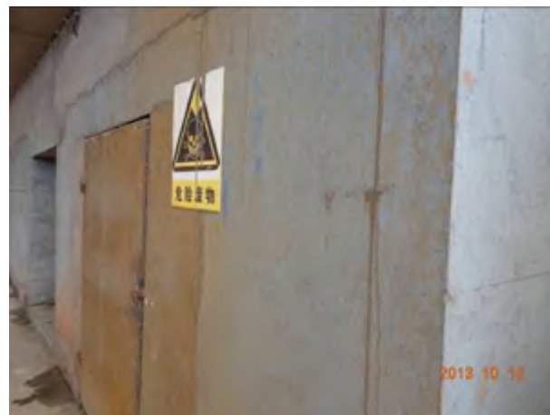
污泥临时堆放场
