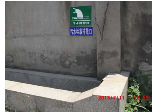
废水总排放口
