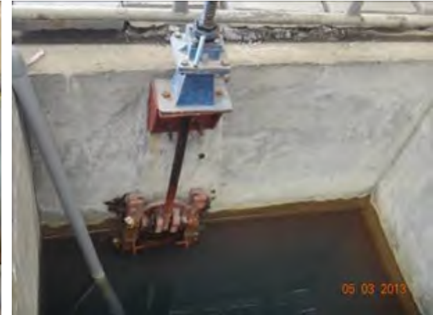
总排放口切断措施
