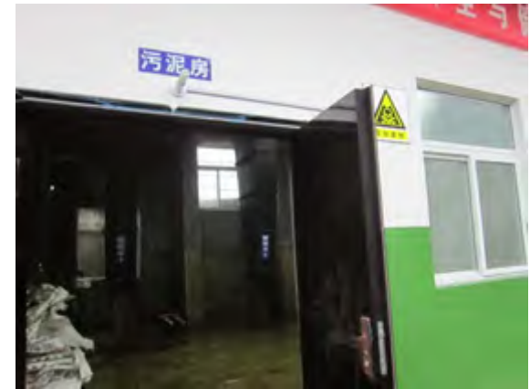
污水站污泥暂存间
