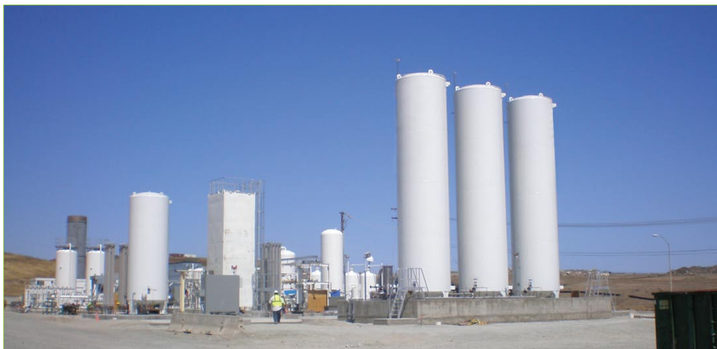
在阿尔塔蒙特，加利福尼亚垃圾填埋场，使用了小型的混合制冷剂循环液化技术。
