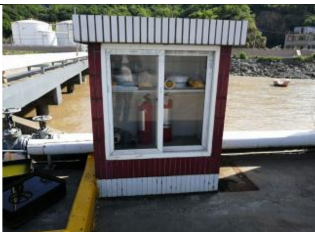
码头上的消防装置
