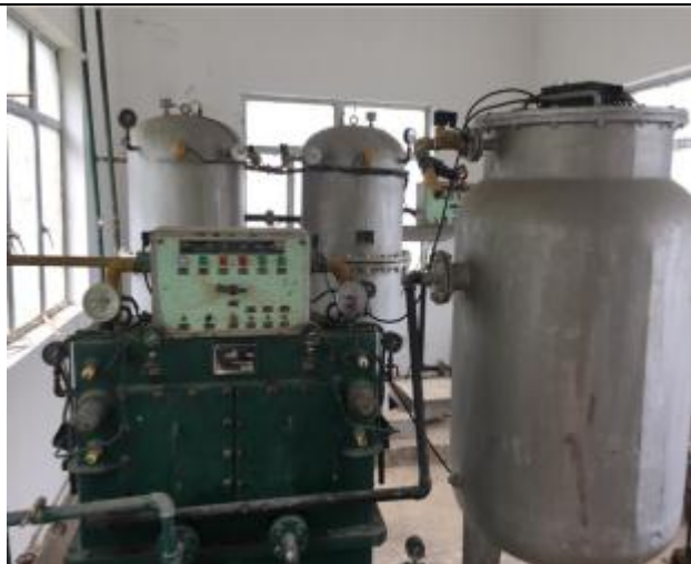
污水处理设施
