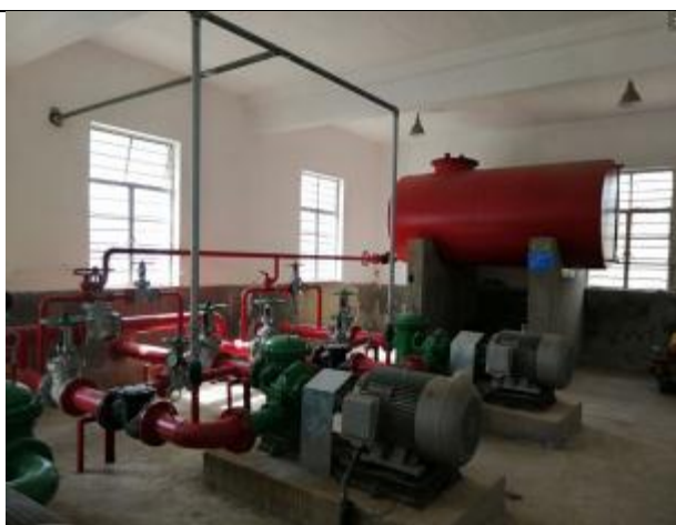
库区消防间（泡沫发生装置）
