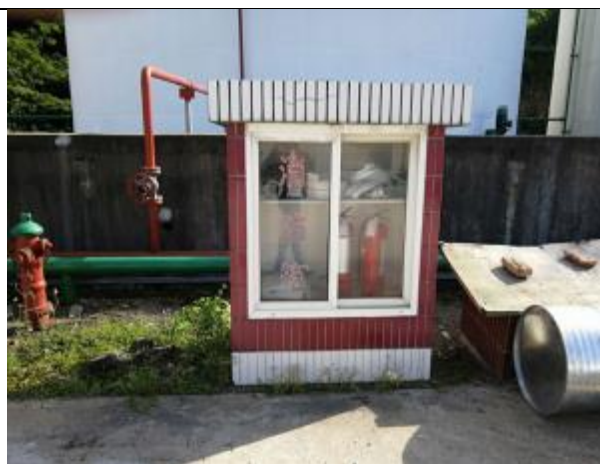
库区消防装置
