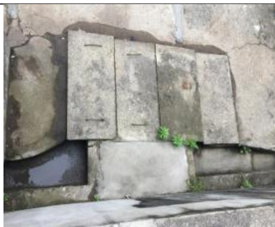
罐区初期雨水收集池
